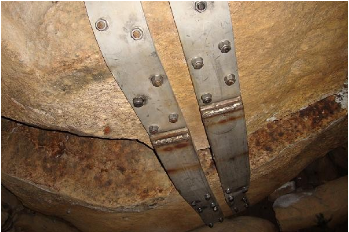
Afstivning af loftet i gravkammeret
